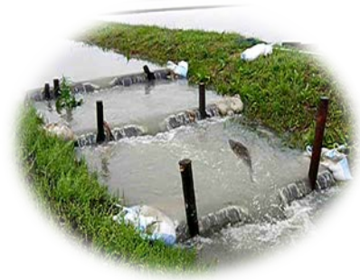
排水路堰上式魚道
