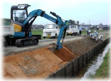
構成員による直営施工
