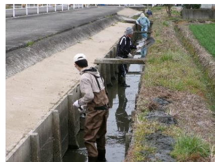
水路の泥上げの様子
