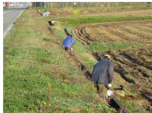
水路の泥上げ作業の様子
