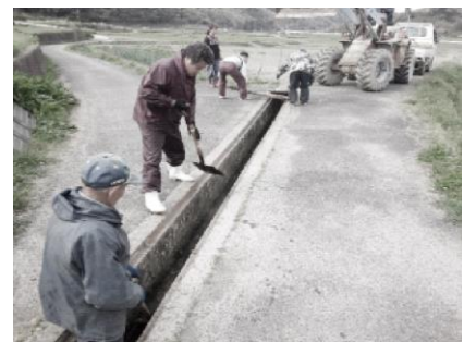
水路の泥上げの様子
