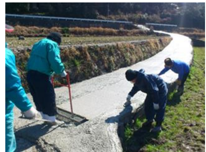
コンクリート舗装の様子
