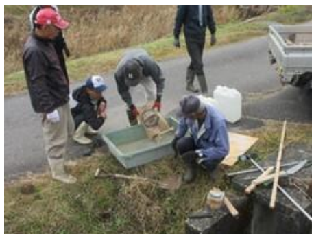
水路の補修作業（直営施工）
