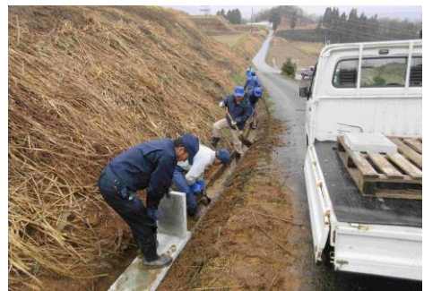
自作の水路蓋の設置
