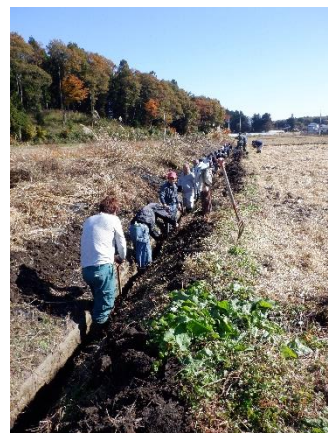
水路の泥上げの様子
