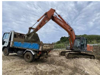
浸透池の泥上げ
