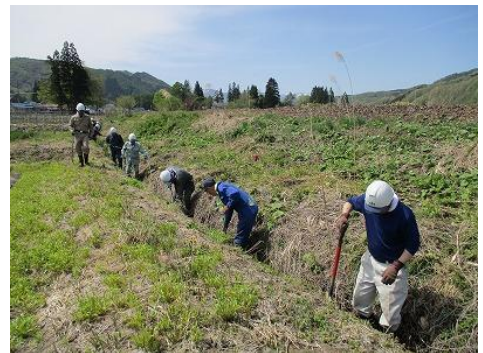
水路の泥上げの様子
