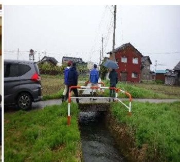
水路等の点検・診断 4/15
