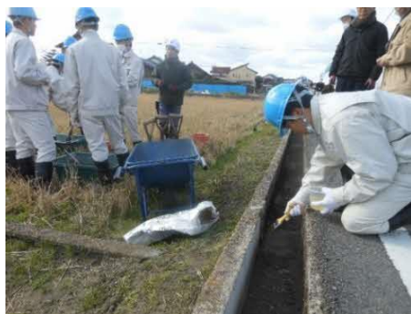
水路のコーティング作業
