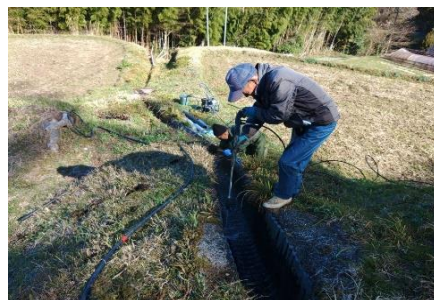
農業用水路の補修作業
