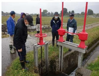
水門等の点検・診断 4/15
