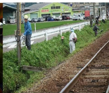
水路・路肩部の草刈り 7/2
