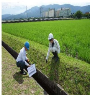
役所保全管理状況立会 6/27
