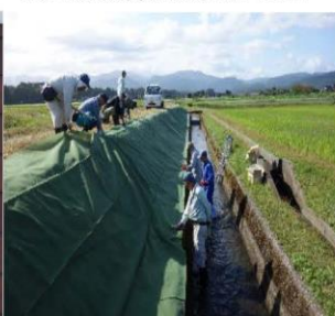
東石黒用水防草シート設置 10/1
