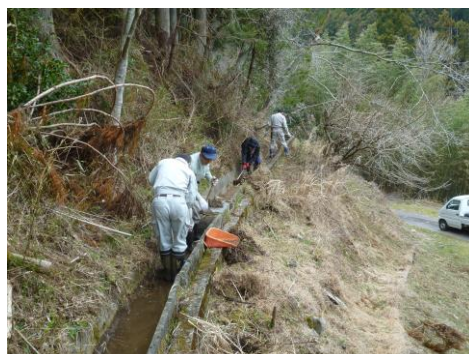
水路の泥上げの様子
