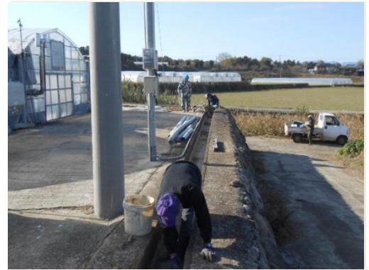
水路補修活動の様子
