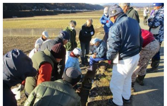
水路補修の実技研修
