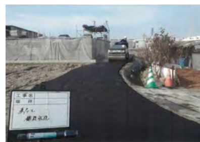
農道舗装の様子
