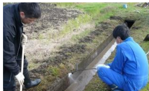
水路補修前の準備作業
