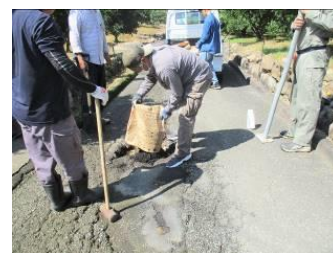
農道の補修作業の様子
