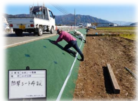
法面への防草シート張り
