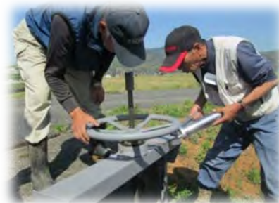
水路バルブの補修
