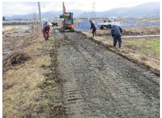
農道補修作業
