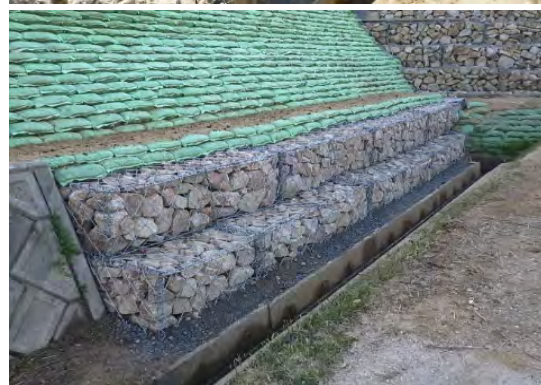
直営施工（ふとん籠工法 かご ）による補修工事
