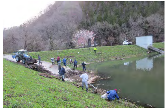
本沢ダム（ため池）清掃作業
