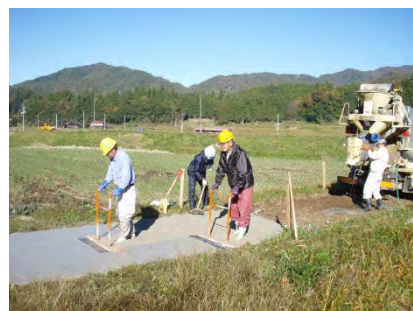
直営施工による農道舗装
