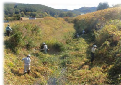
排水路の草刈り
