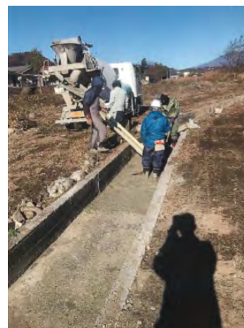
直営施工による水路の補修
