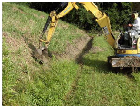
法面補修(獣被害)活動の様子
