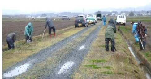
水路の泥上げ作業
