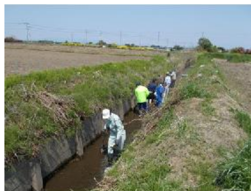
排水路の泥上げ作業
