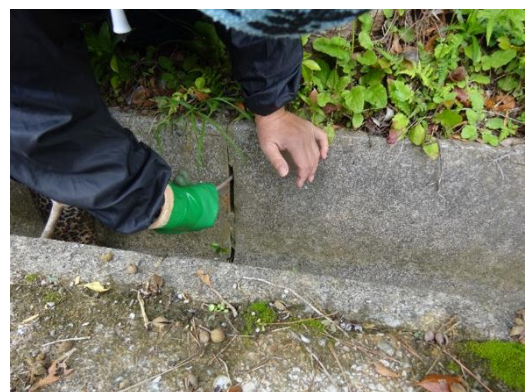
U字溝の目地を補修する様子
