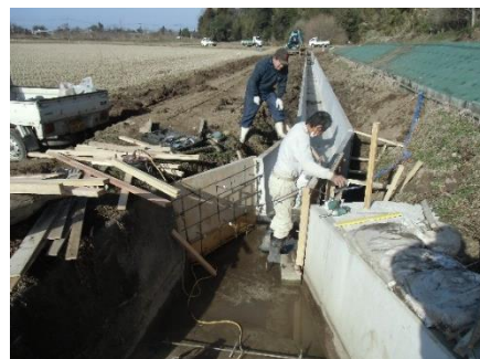
水路の更新工事 資源向上（長寿命化）
