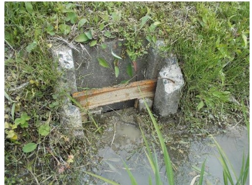
田んぼダム取組状況の様子
