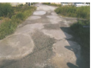
農道の窪みの補修
