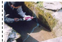
水路のひび割れ補修
