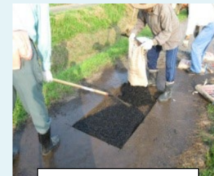
農道の部分補修
