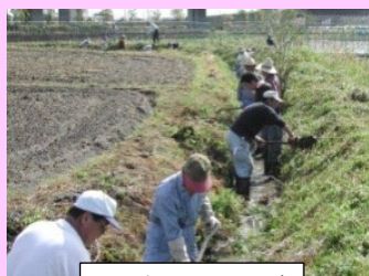
水路の泥上げ
