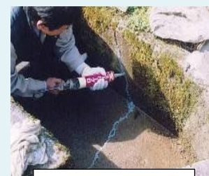
ひび割れの補修
