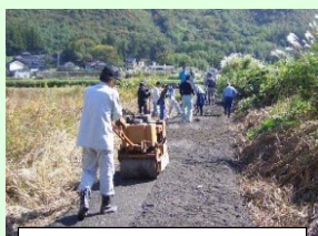
未舗装農道の舗装
