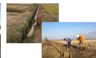
水路の軽微な補修等
