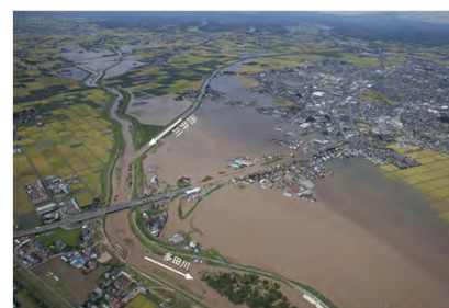
合流部での浸水状況
