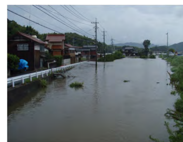
小河川からの浸水状況
