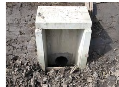
落水口の整備
