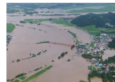
本川からの浸水状況
