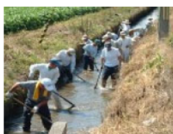
水路の泥上げ
