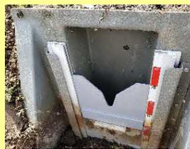
降雨時は、V字部分の断面に応じて排水されるため、堰板操作が不要。(最大で10cmの雨水の貯留が可能)
