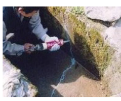
水路のひび割れ補修
