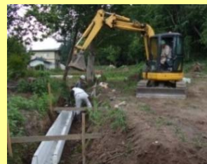
自主施工の実施
