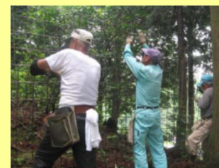
獣害柵の補修管理
