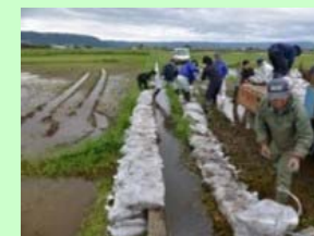
土のうの積み上げ作業
