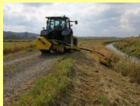
排水路法面の草刈
