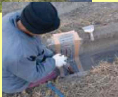
【地域住民による目地詰めの様子】
