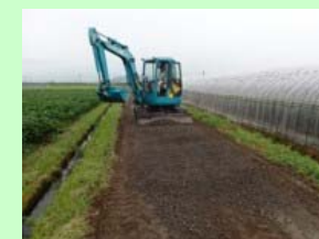
農道の復旧状況
