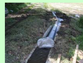
仮設配管の敷設状況
