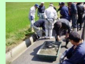
目地詰め作業
