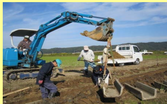
自主施工による水路の布設替え
