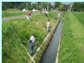
水路法面の草刈り
