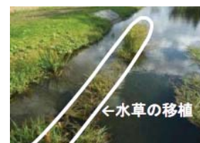
コンクリートフリーウムを利用し水草を移植
