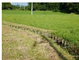
景観に配慮した木柵水路
