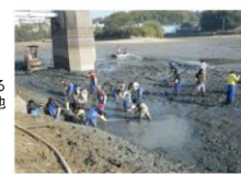
漁業者との共同による かいぼり作業（ため池を 池干し、土砂上げ）
