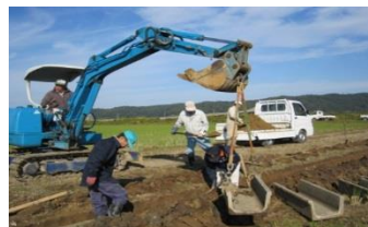
水路の布設替え
