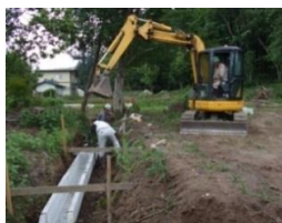
直営施工の実施状況
