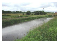
水質保全のための沈砂池
