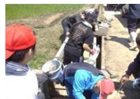
ボランティアによる復旧作業
