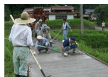
集落間連携による 農道の舗装
