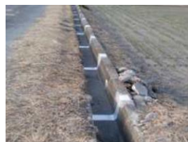
目地詰め補修後の水路
