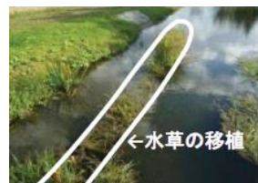
コンクリートフリウムを利用し水草を移植
