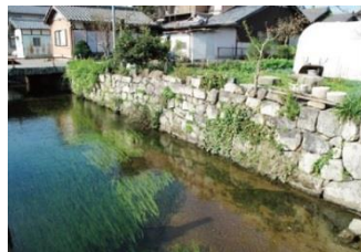
石積みの疎水
