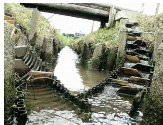
水田魚道の設置
