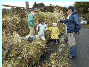
点検・機能診断
