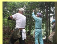
獣害柵の補修管理
