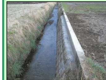
＜復旧した被災箇所＞
