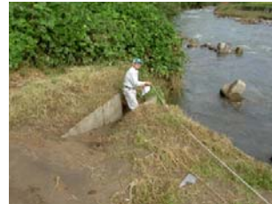
被災状況調査
