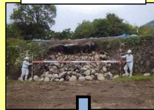
＜被災箇所の復旧＞
