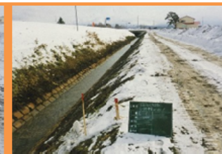
土砂上げ補修後
