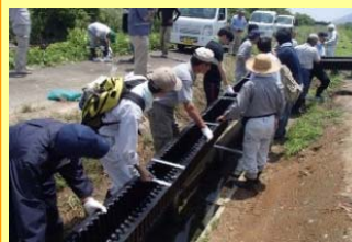
水田魚道の設置
