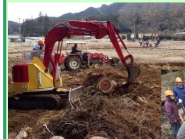
流木の撤去作業
