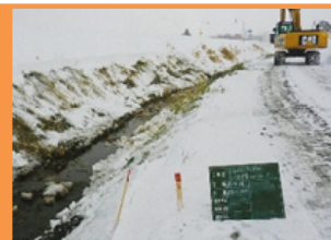
土砂上げ補修前
