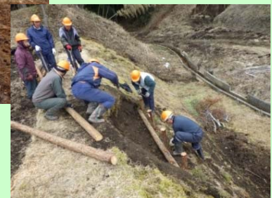
崩落した法面の応急措置
