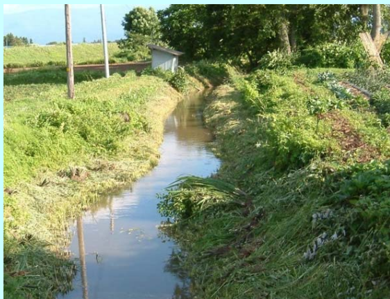
地区内の用排兼用の土水路
