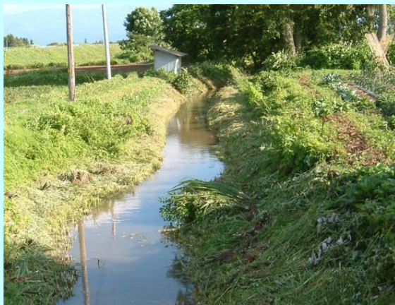
地区内の用排兼用の土水路
