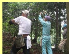
獣害柵の補修管理
