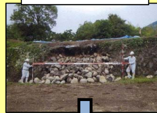
<被災箇所の復旧>
