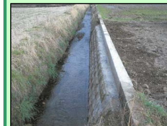
<復旧した被災箇所>
