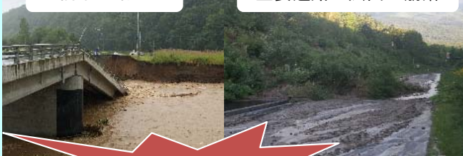
平成28年豪雨災害発生
