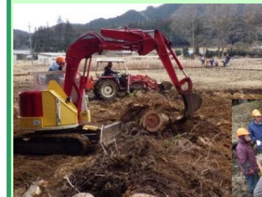
流木の撤去作業
