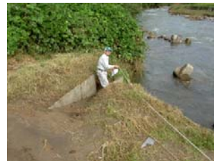
被災状況調査
