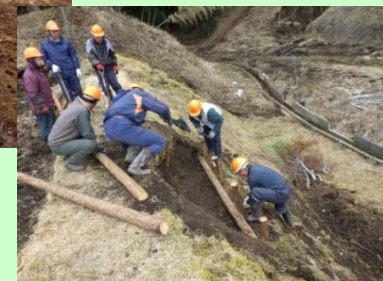
崩落した法面の応急措置
