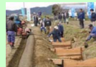
集落総出で魚道を設置
