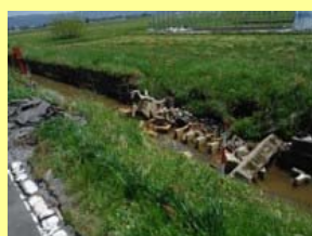
水路及び農道の破損状況
