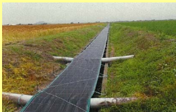
防草シートによる排水路の遮光
