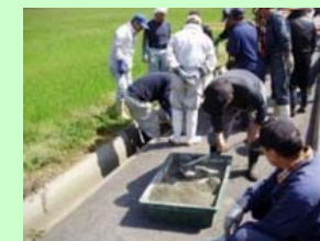
目地詰め作業
