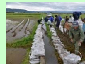
土のうの積み上げ作業
