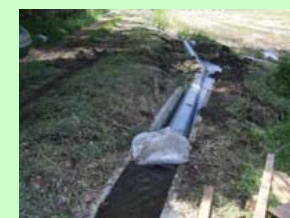
仮設配管の敷設状況
