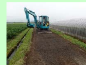
農道の復旧状況
