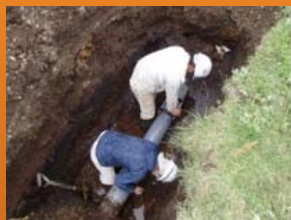
パイプラインの復旧状況
