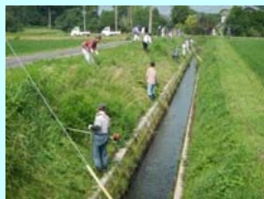
水路法面の草刈り
