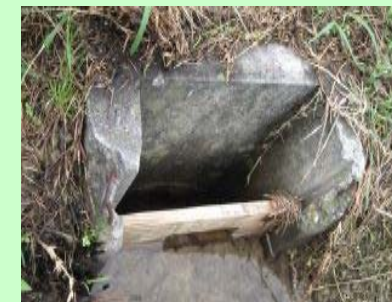
堰板による田んぼダム
