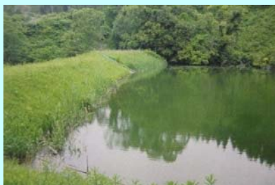
地域の貴重な水源であるため池
