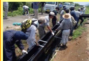
水田魚道の設置
