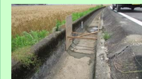
大きな破損箇所も、ベニア板の型枠を使って補修
