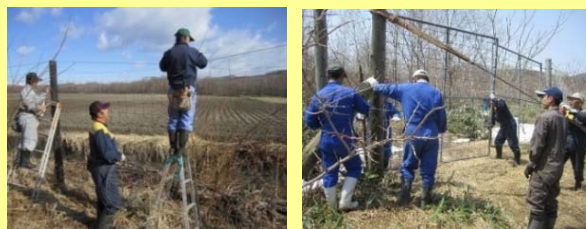
地域住民による柵の点検
