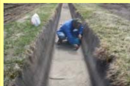
水路の目地補修
