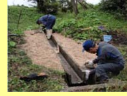
直営施工(水路の補修)
