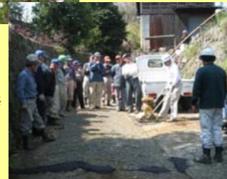
農道の簡易補修
