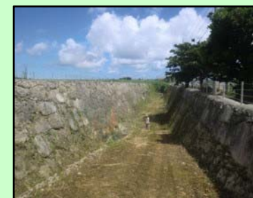
作業後の浸透池
