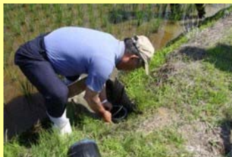
田んぼダム用 水位調整管の 設置
