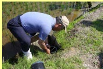
田んぼダム用 水位調整管の 設置
