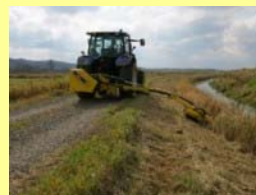
排水路法面の草刈
