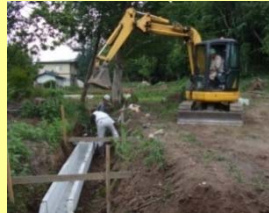
自主施工の実施
