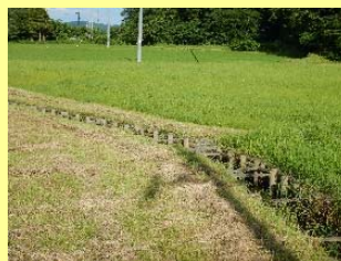
景観に配慮した木柵水路
