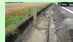
大きな破損箇所も、ベニア板の型枠を使って補修
