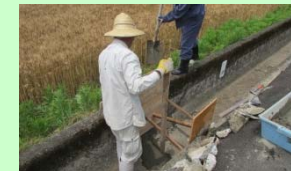
大きな破損箇所も、ベニア板の型枠を使って補修
