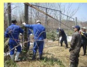
地域住民による柵の補修
