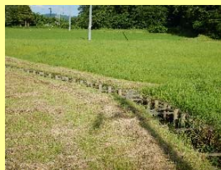
景観に配慮した木柵水路
