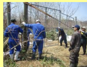
地域住民による柵の補修
