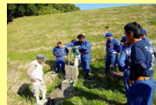
消防団と連携した点検の様子
