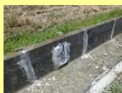
慣れた手つきでコンクリート練りから目地補修まで
