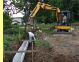
自主施工の実施
