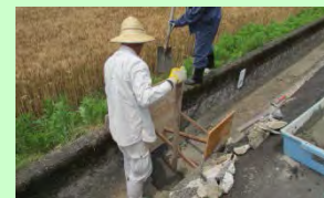
大きな破損箇所も、ベニア板の型枠を使って補修
