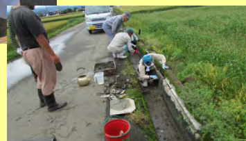
慣れた手つきでコンクリート練りから目地補修まで
