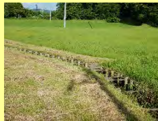
景観に配慮した木柵水路
