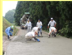
直営施工による農道舗装
