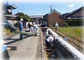
サポート隊の技術支援による水路補修
