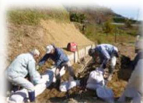
サポート隊の技術支援による法面補修
