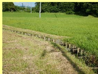
景観に配慮した木柵水路
