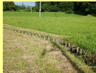
景観に配慮した木柵水路
