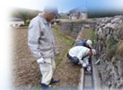
9月～3月に老朽化施設等の軽微な補修をサポート隊が中心になって実施
