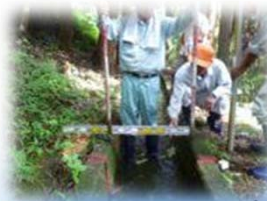
施設の機能診断を実施
