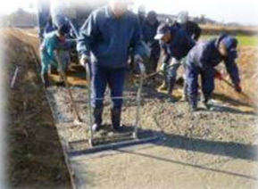
サポート隊の技術支援による農道の簡易舗装
