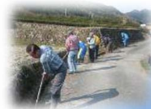
水路や農道側溝の泥上げ
