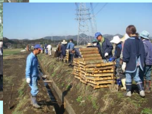
【水路の蓋掛け】 （カエル蓋）
