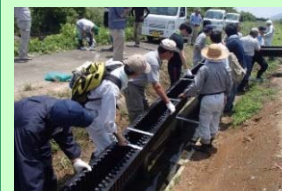
水田魚道の設置
