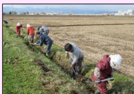
水路の泥上げ
