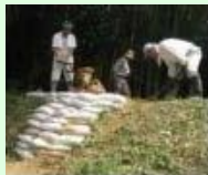
漏水箇所の補修
