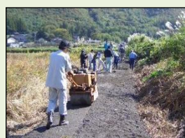
未舗装農道の舗装
