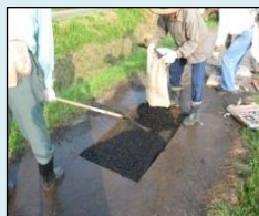
農道の部分補修
