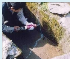
ひび割れの補修
