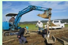
コンクリート水路の更新
