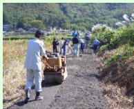
未舗装農道の舗装
