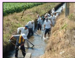
水路の泥上げ
