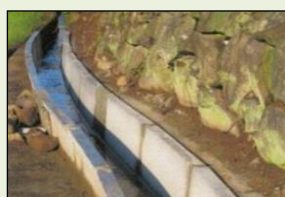
素堀り水路からの更新
