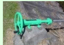
ゲート、バルブの更新
