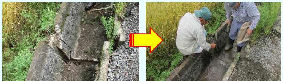
地震により破損した水路を地域共同で補修（外注も可能）
