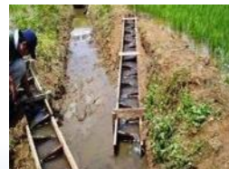
水田魚道の設置
