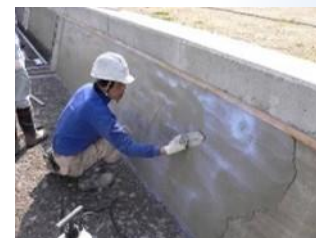
老朽化した水路壁のコーティング
