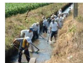
水路の泥上げ
