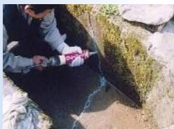
水路のひび割れ補修
