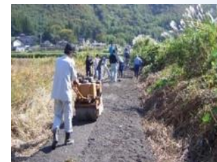
未舗装の農道をアスファルトで舗装
