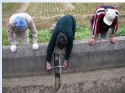
施設の機能診断
