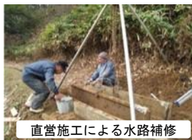
直営施工による水路補修
