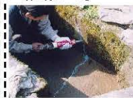
水路のひび割れ補修
