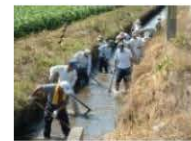
水路の泥上げ
