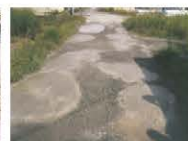
農道の窪みの補修
