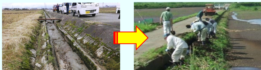
地震により水路に堆積した土砂を地域共同で撤去（外注も可能）
